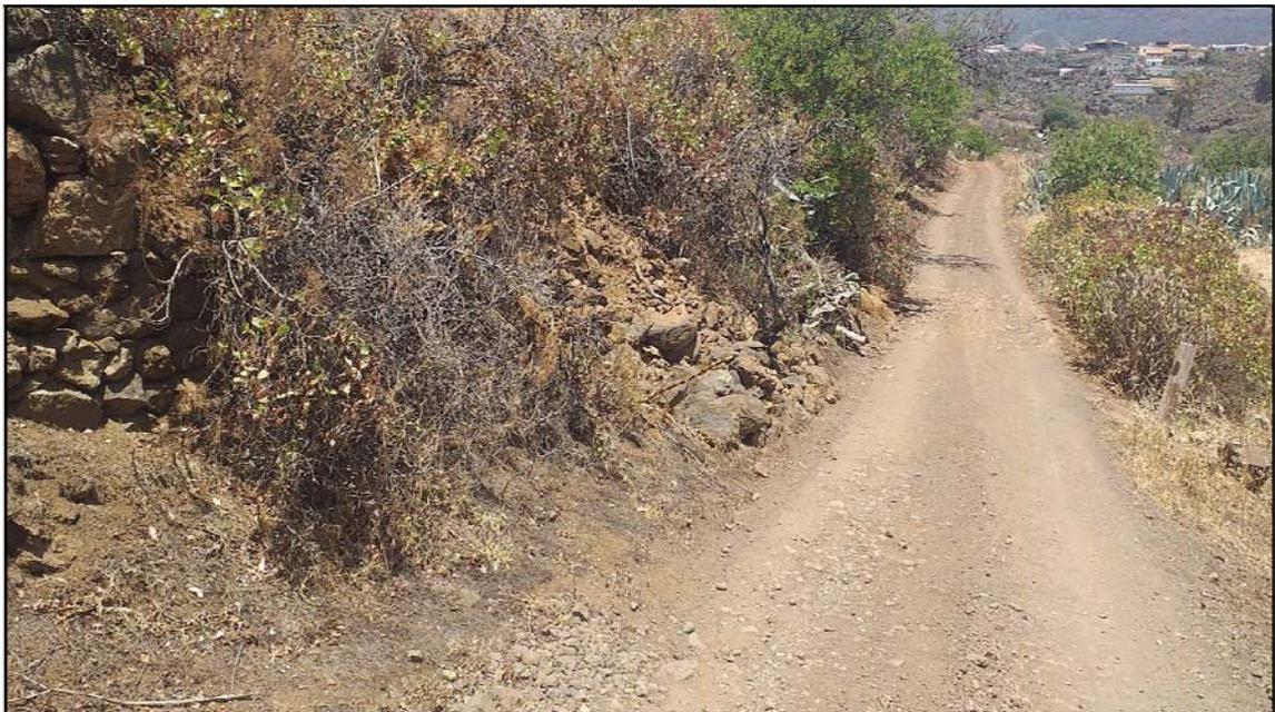
FOTO 6: Muro derruido en el margen izquierdo, pk 900.
