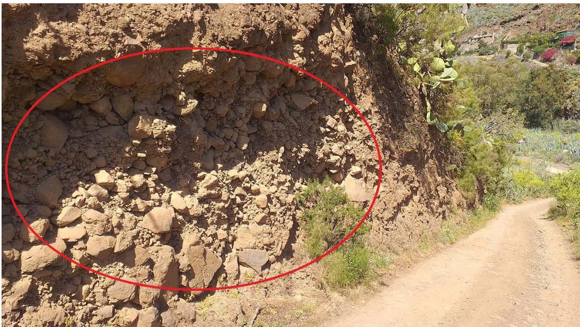
Imagen 5: Oquedades de material suelto en la base del talud. PK 1.260.
